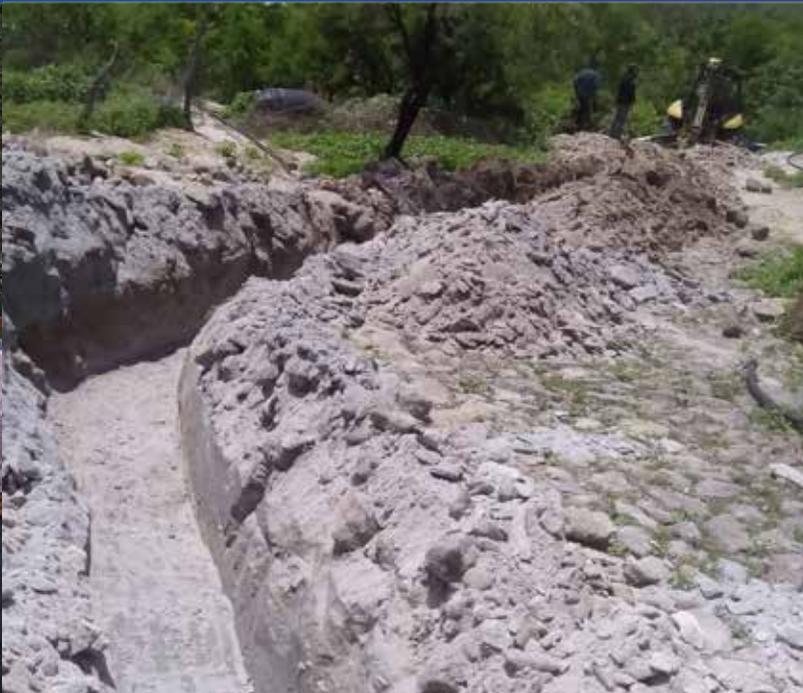
Suministro e instalación de 3,803.10 ml de tubería de PVC hidráulico de 2" (50 mm) de diámetro RD-26
