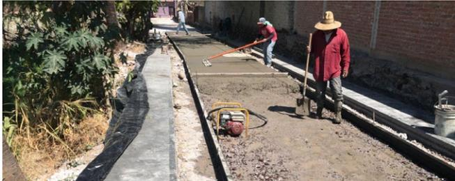
Obras construcción con pavimentación de concreto ecológico en calle Asilo en la Comunidad de La Mezquitera Sur.
